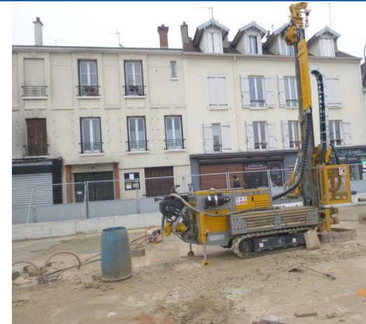
Forage pour caractérisation des déblais Gare de Saint-Maur-Créteil - (Bureau Veritas)
