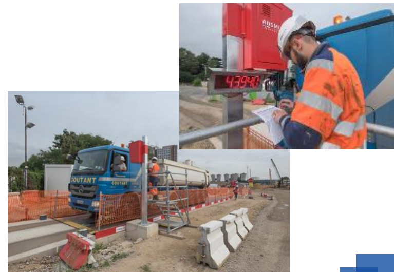
Pesée des déblais - Gare IGR - (SGP)
